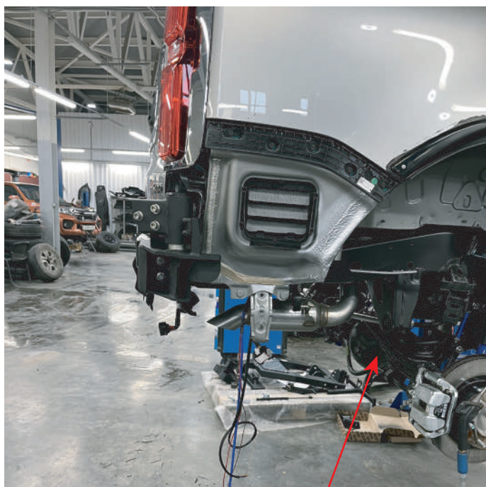
Установка закладной гайки №38 через боковое отверстие рамы
